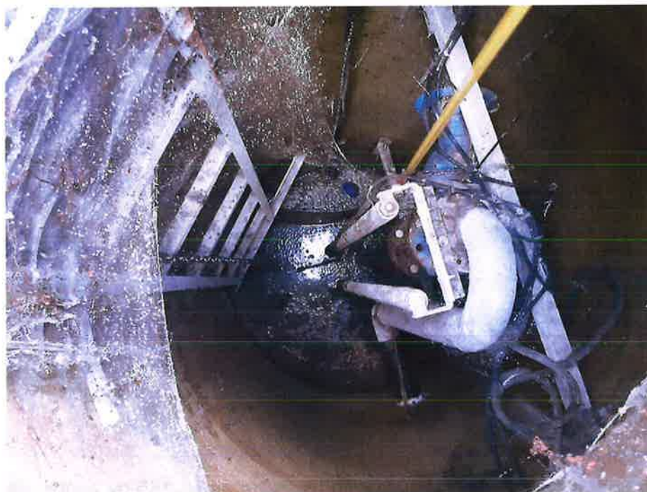
Zdjęcie nr 8 – Modernizacja przepompowni ścieków w Malinówce. Źródło: Archiwum własne
