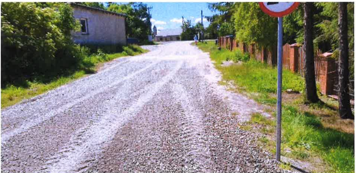
Zdjęcie nr 60 Utwardzenie drogi w miejscowości Konieczki, Źródło: Archiwum własne
