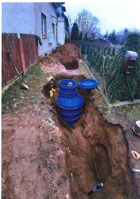
Zdjęcie nr 25 – Montaż studni pomiarowej w miejscowości Straduny, Kajki 9. Źródło: Archiwum własne
