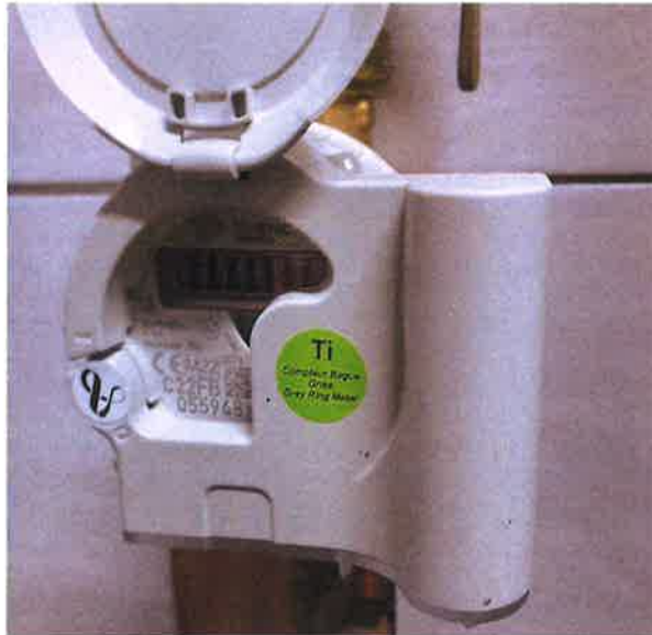
Zdjęcie nr 74 Dostawa wodomierzy z projektu. Wodomierz Altair DN 15 z nakładką radiową. Źródło: Archiwum własne.
