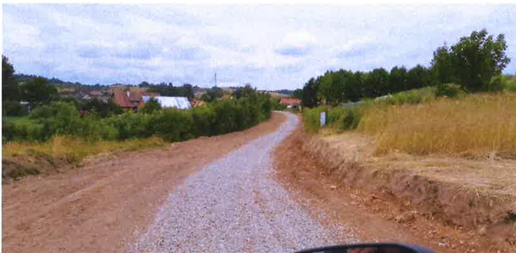
Zdjęcie nr 64 Wykonanie drogi w m. Oracze, Źródło: Archiwum własne
