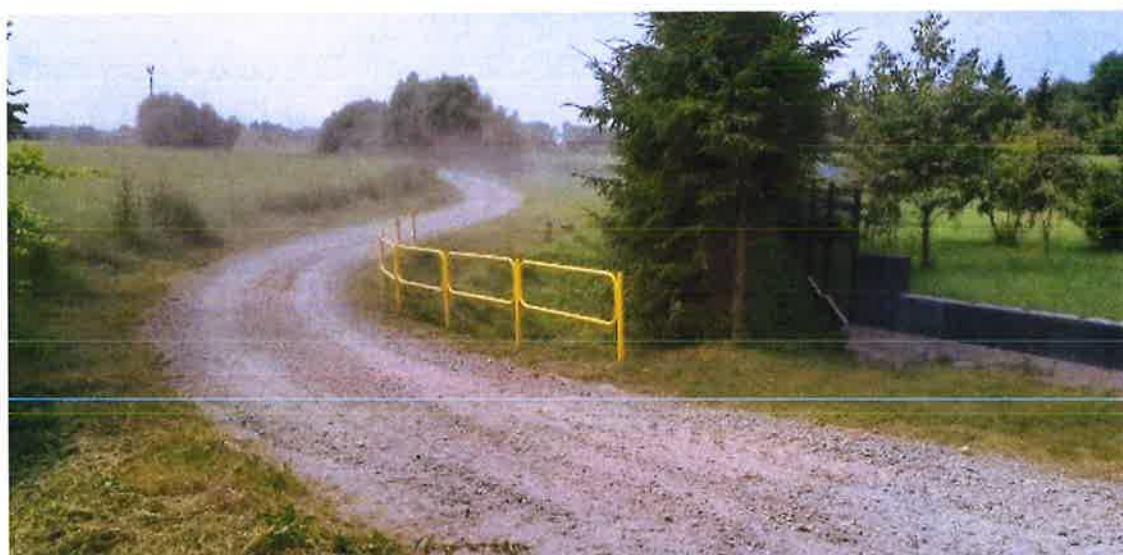
Zdjęcie nr 62 Skarpowanie i utwardzenie drogi w Szarejkach, Źródło: Archiwum własne
