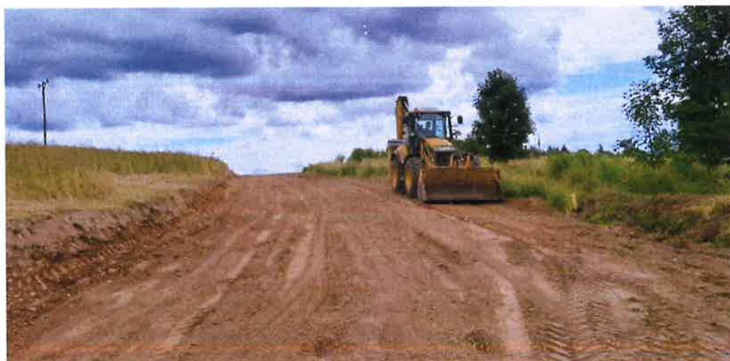
Zdjęcie nr 63 Wykonanie drogi w m. Oracze, Źródło: Archiwum własne
