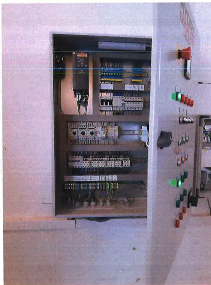
Zdjęcie nr 13– Modernizacja Stacji Podnoszenia Ciśnienia w Nowej Wsi Etckiej. Źródło: Archiwum własne
