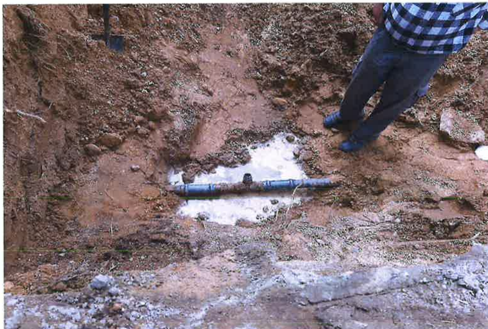
Zdjęcie nr 31– Awaria na sieci wodociągowej na ul. Małeckich w miejscowości Nowa Wieś Etcka. Źródło: Archiwum własne
