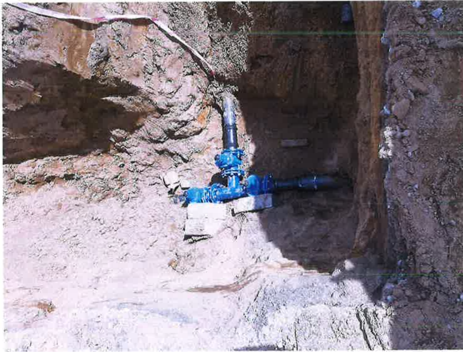
Zdjęcie nr 4 – Inwestycja budowy sieci wod.-kan. w miejscowości Barany- Chruściele. Źródło: Archiwum własne
