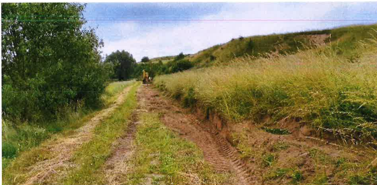
Zdjęcie nr 61 Skarpowanie i utwardzenie drogi w Szarejkach, Źródło: Archiwum własne
