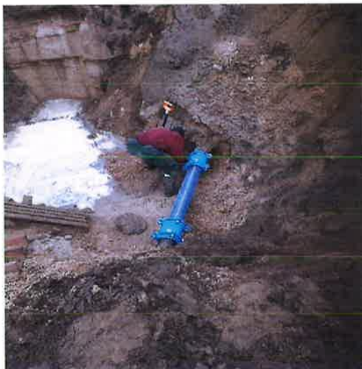
Zdjęcie nr 27 – Awaria przy przebudowie wodociągu przy budynku Arhelan.. Źródło: Archiwum własne
