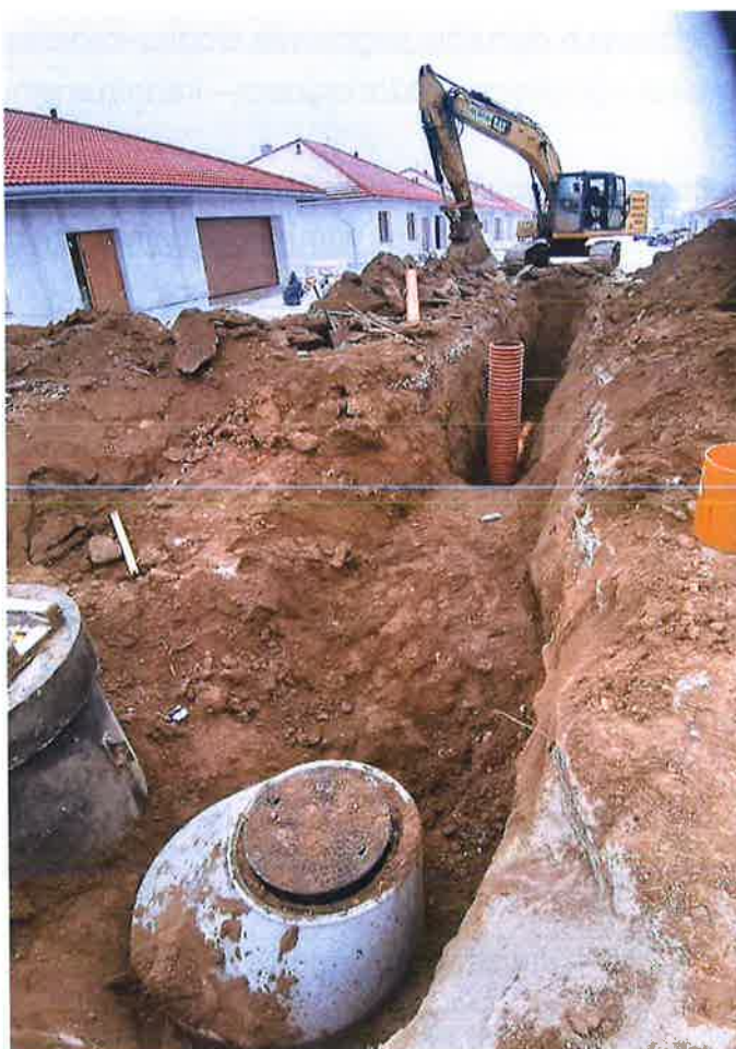
Zdjęcie nr 1 – Inwestycja budowy sieci wod.-kan. w miejscowości Barany- Chruściele. Źródło: Archiwum własne
