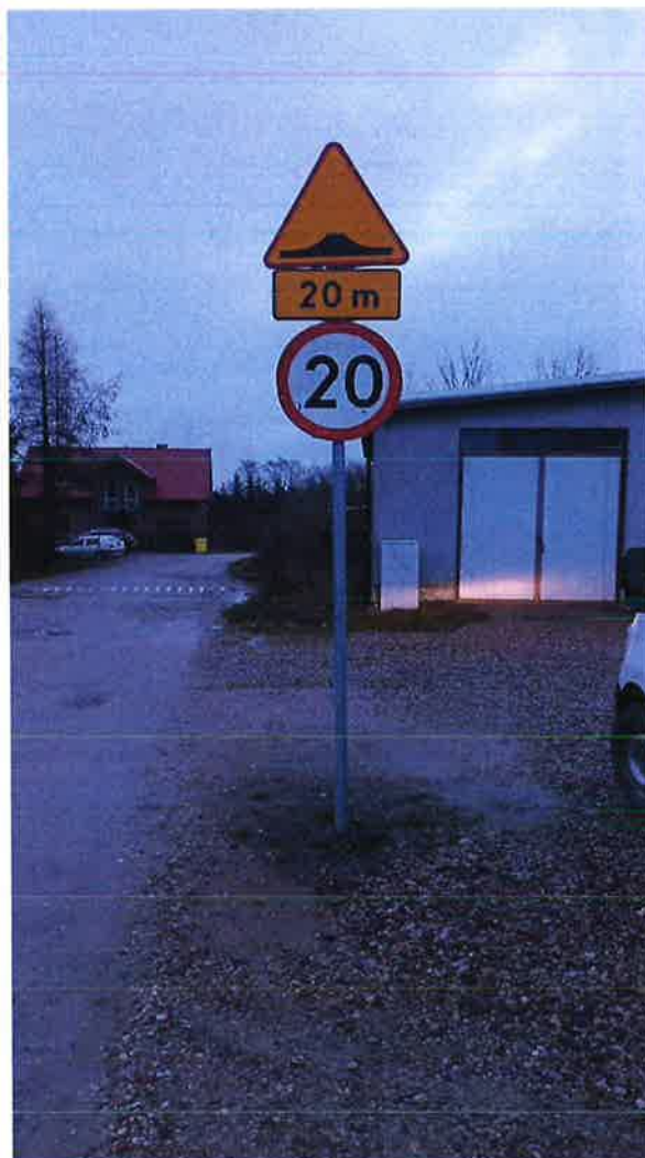
Zdjęcie nr 54 Montaż znaków drogowych, Źródło: Archiwum własne
