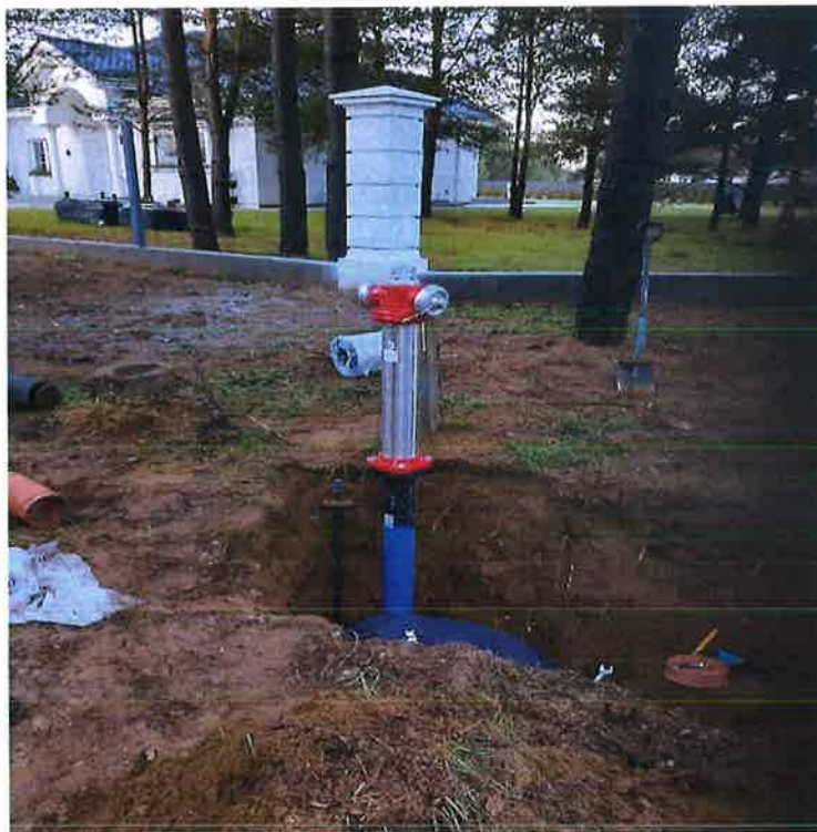
Zdjęcie nr 15 – Wymiana hydrantu ppoż. w miejscowości Barany ul. Żabie Oczko. Źródło: Archiwum własne
