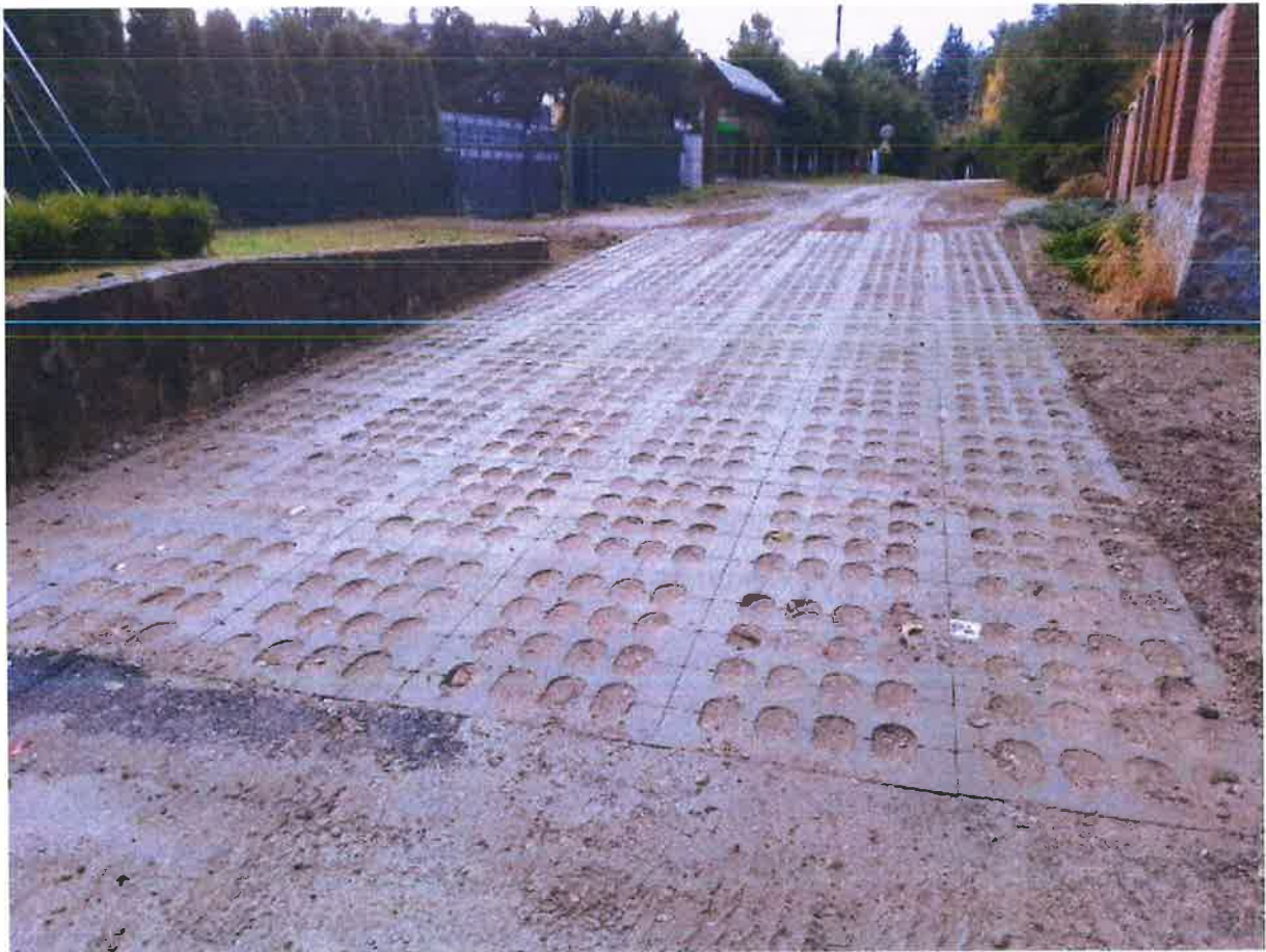
Zdjęcie nr 42 Wykonanie pojazdu we wsi Małkinie z płyt typu yomb
