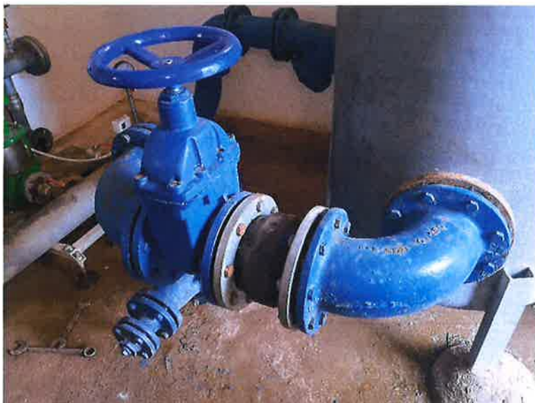
Zdjęcie nr 10– Modernizacja Stacji Podnoszenia Ciśnienia w Nowej Wsi Ełckiej. Źródło: Archiwum własne
