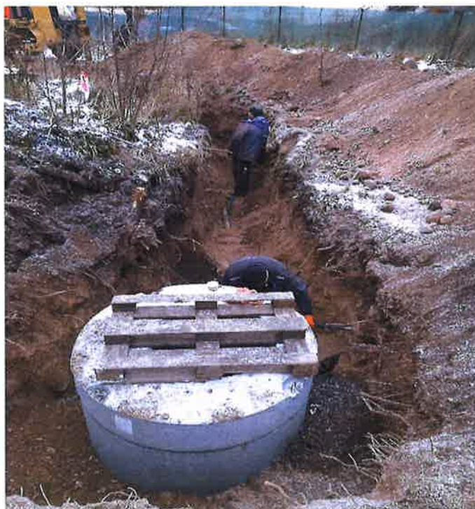
Zdjęcie nr 33– Budowa sieci wodno-kanalizacyjnej w miejscowości Piaski dz. 83/11. Źródło: Archiwum własne
