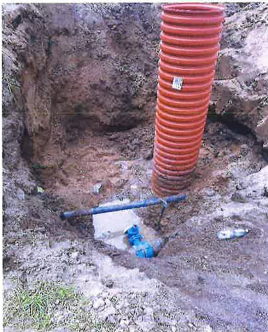
Zdjęcie nr 34– Budowa sieci wodno-kanalizacyjnej w miejscowości Bartosze dz. 53/12. Źródło: Archiwum własne
