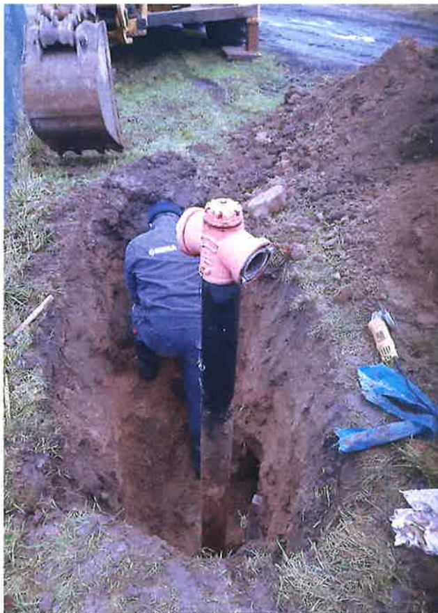
Zdjęcie nr 14 – Wymiana hydrantu ppoż. w miejscowości Regiel. Źródło: Archiwum własne
