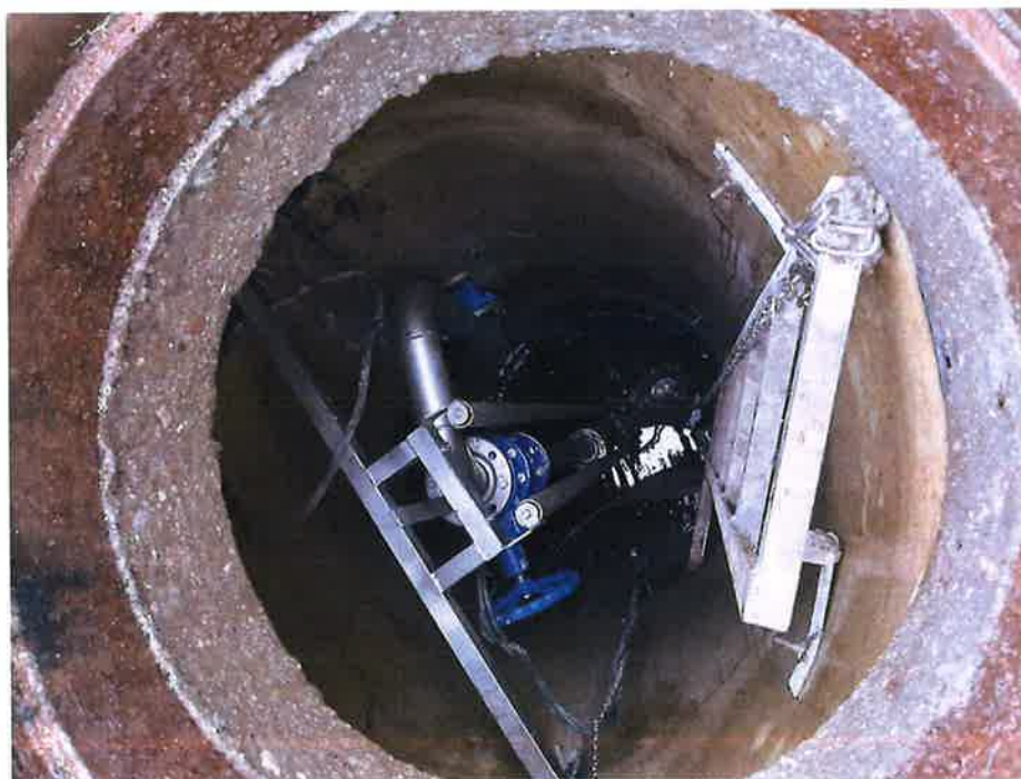
Zdjęcie nr 9 – Modernizacja przepompowni ścieków w Malinówce. Źródło: Archiwum własne
