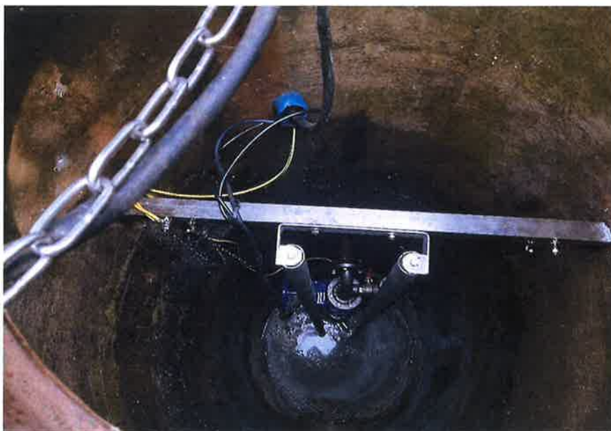
Zdjęcie nr 21 – Modernizacja przepompowni ścieków w miejscowości Lega. Źródło: Archiwum własne
