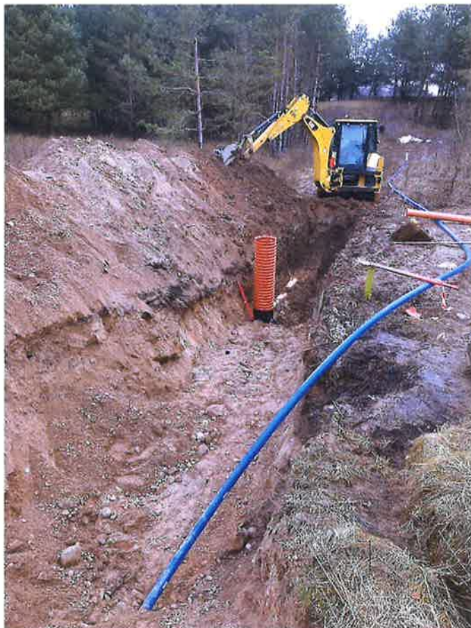
Zdjęcie nr 32– Budowa sieci wodno-kanalizacyjnej w miejscowości Piaski dz. 83/11. Źródło: Archiwum własne
