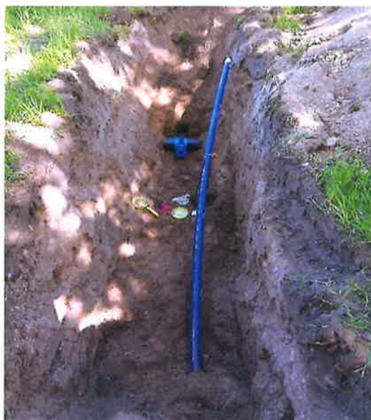
Zdjęcie nr 36– Budowa sieci wodno-kanalizacyjnej w miejscowości Bartosze dz. 54/21, 47/1, 352. Źródło: Archiwum własne
