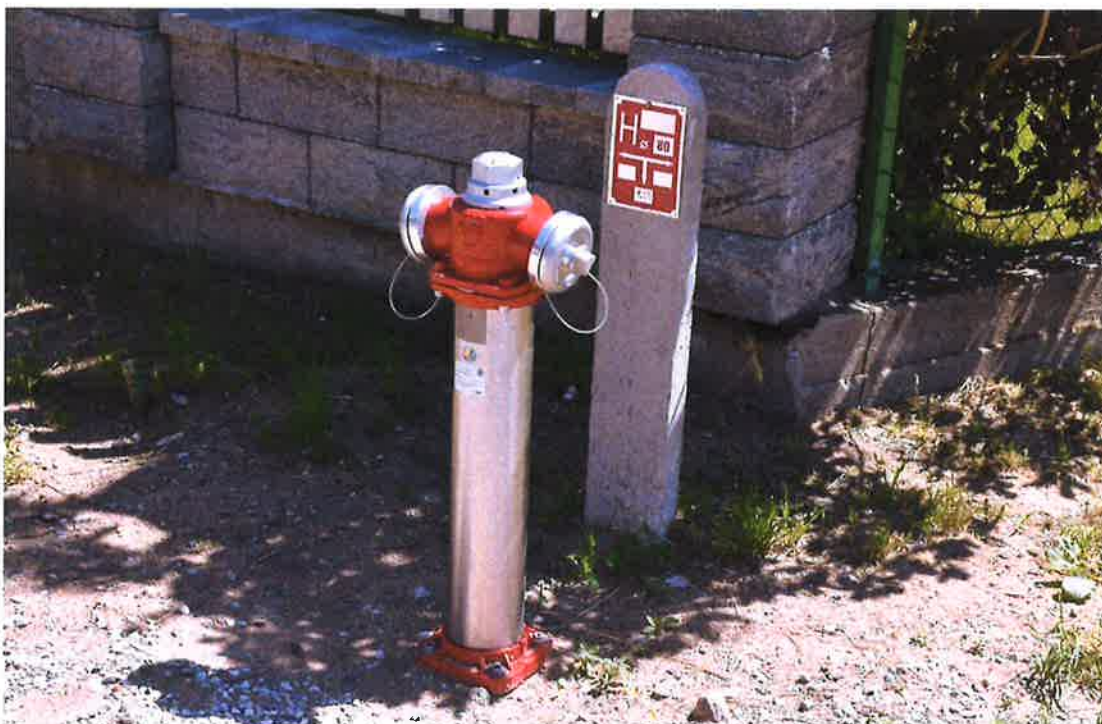
Zdjęcie nr 2 – Inwestycja budowy sieci wod.-kan. w miejscowości Barany- Chruściele. Źródło: Archiwum własne
