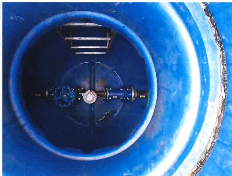
Zdjęcie nr 22– Montaż wodomierza w studni pomiarowej na potrzeby GDDKIA. Źródło: Archiwum własne
