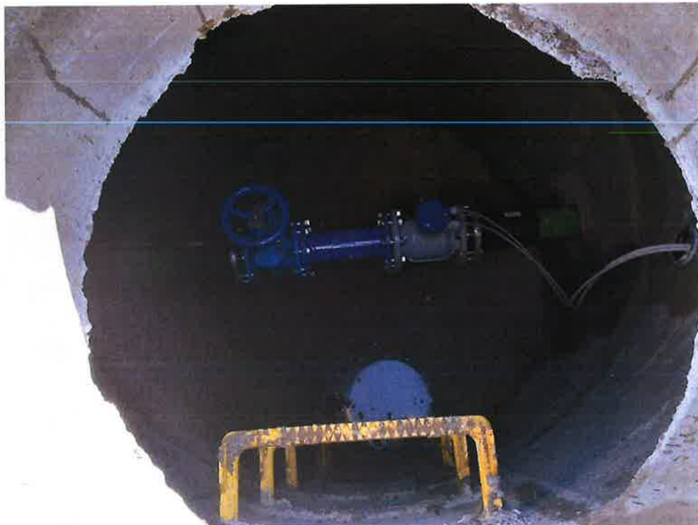
Zdjęcie nr 5 – Inwestycja budowy sieci wod.-kan. w miejscowości Barany- Chruściele. Źródło: Archiwum własne
