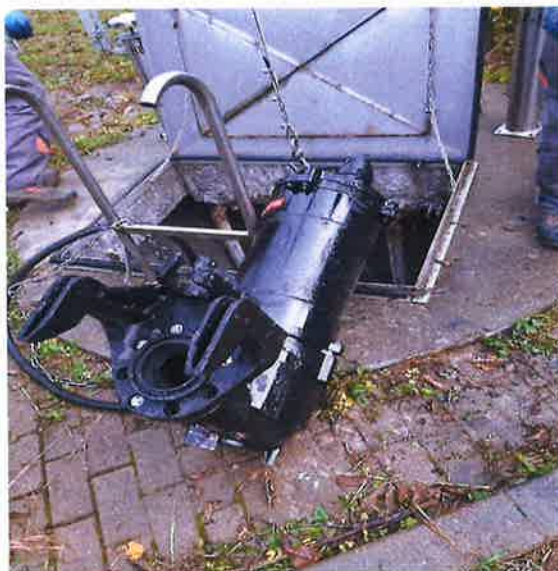
Zdjęcie nr 24 – Wymiana pomp w przepompowni ścieków w Bartoszach. Źródło: Archiwum własne
