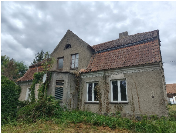
Zdjęcie 11. Budynek mieszkalny z 1936 r. w miejscowości Płociczno. Przykład tynkowanej zabudowy z charakterystycznym dachem typu gambrel z umiejscowioną centralnie wystawką. Fot. własna, 2024
