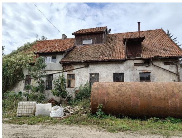
Zdjęcie 30. Gorzelnia w Stradunach, ob. opuszczona. Fot. własna, 2024
