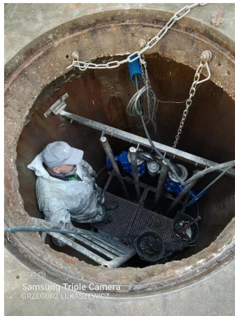
Rys. nr 6 przepompownia Chelchy po modernizacji
